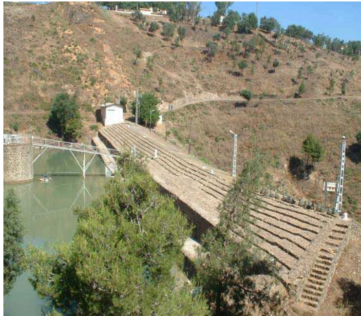
Figure (4,11) : Digue du barrage Meurad.
