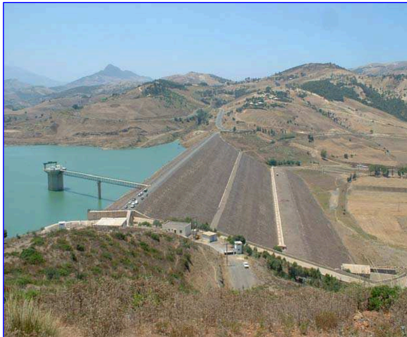
Figure (4,12) : Digue du barrage Boukerdane.
