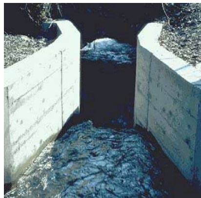
Figure (2,6) : Canal Venturi.
