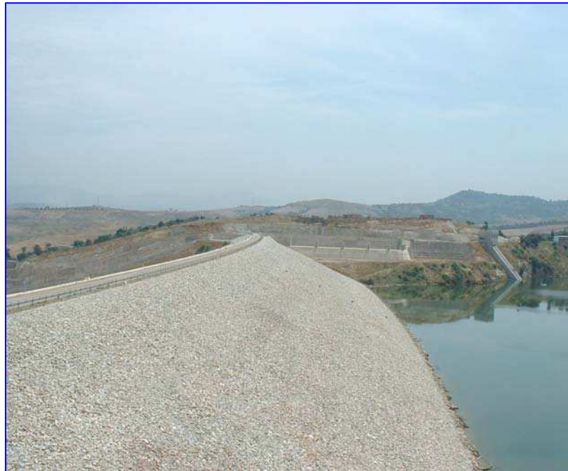
Figure (4,3) : Digue du barrage.
