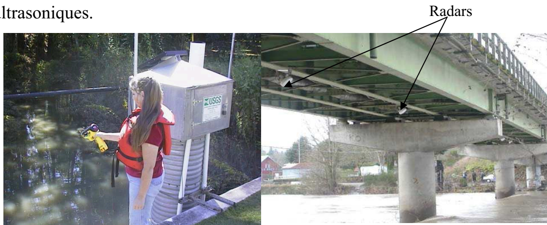
Figure (2,3) : Mesures à l'aide d'ultrasons (USGS).
