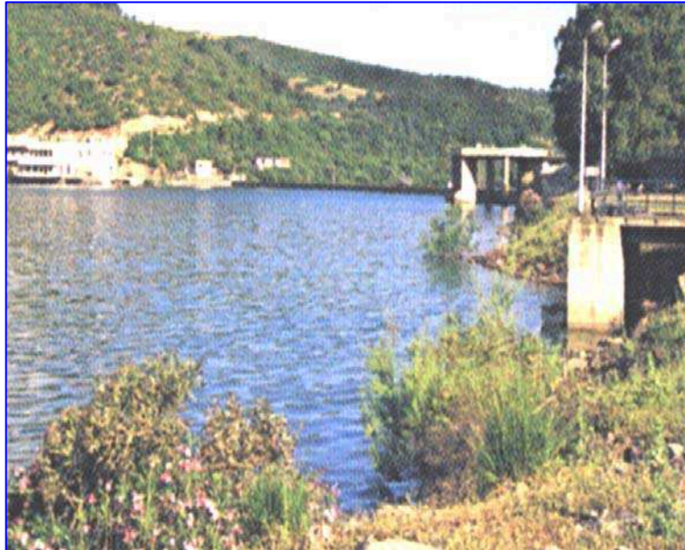
Figure (4,7) : Digue du barrage El Hamiz.
