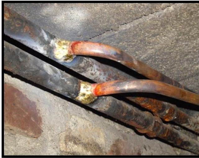
Cuivre et acier noir dans une installation
