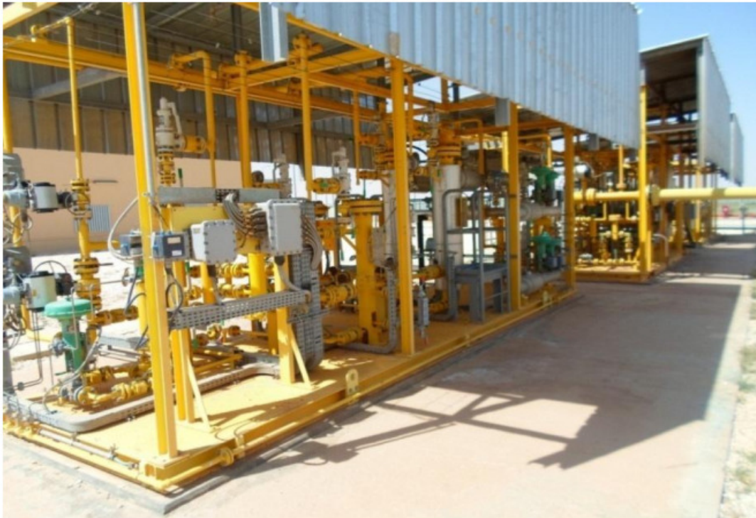
Figure 4: Système de production de gaz combustible
