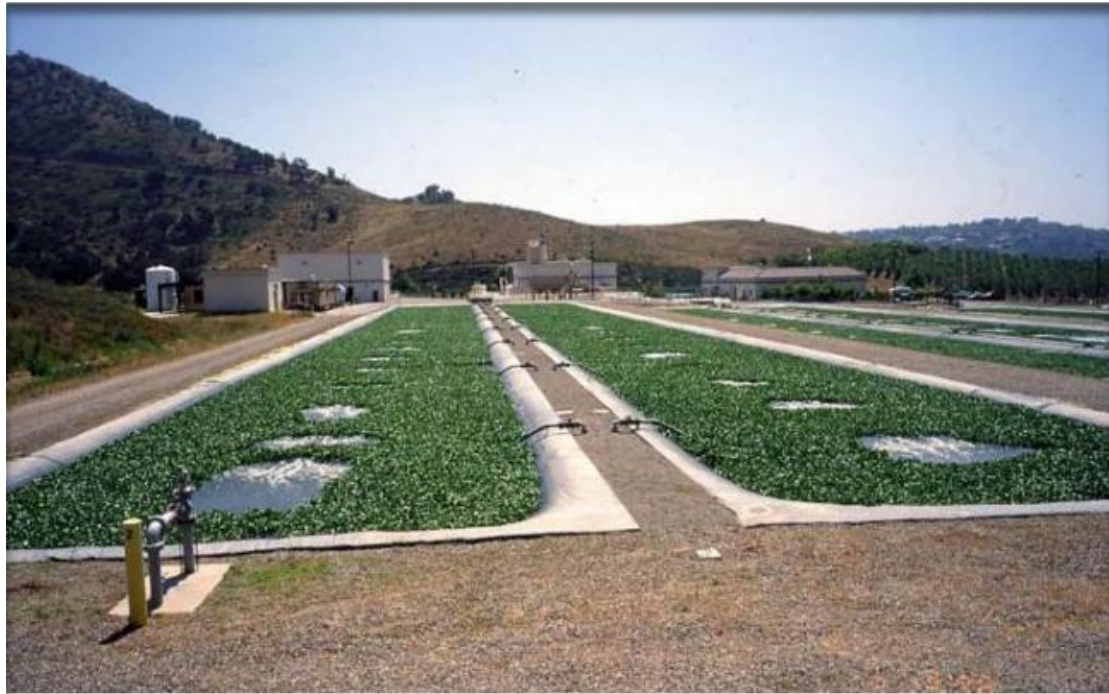
الشكل (II-1): يبين إحدى محطات المعالجة بالنباتات الطافية بالولايات المتحدة الأمريكية (عبد الرزاق التركماني, 2009)
