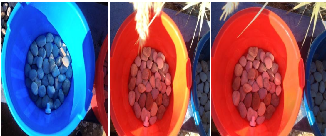
الشكل(I-3): ملء قاع الحوض بالحصى (صورة خاصة)
