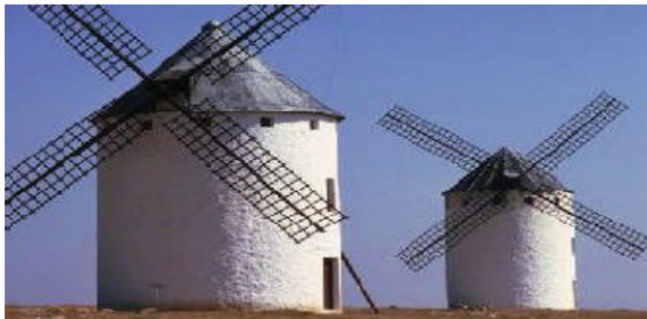
Figure 1.2: Photographie de deux moulins à vent. [4]
