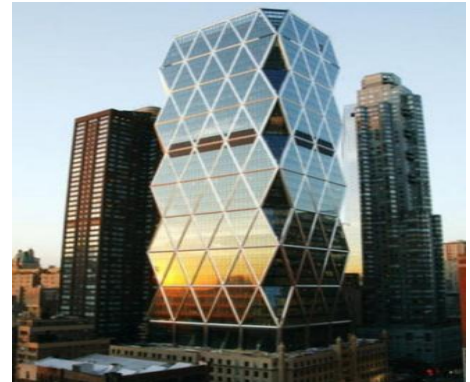
Figure28 : hearst tower (L'utilisation de réducteurs de transfert de chaleur)
