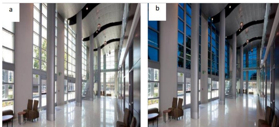
Figure 20 : Vitrage électro chrome : état claire (a) et état teinté (b) Source : DR attache Amel –nouveau matériau2021
