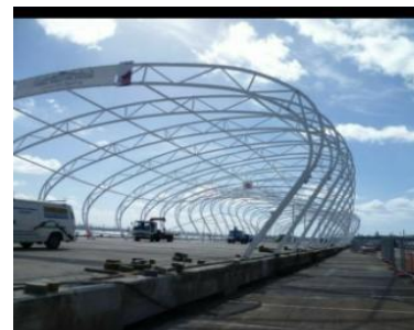
Figure245: l'utilisation de nouveaux matériaux. Source : auteur2021
