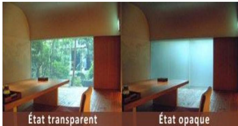
Figure 19 : Vitrage à cristaux liquides Source: DR attache Amel –nouveau matériau 2021
