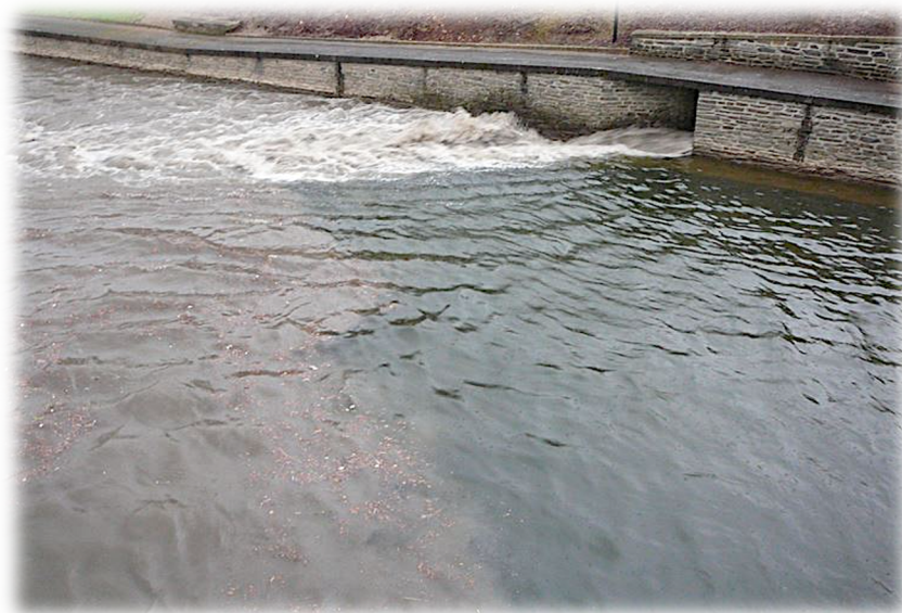
Figure 5 : Les rejets urbains de temps de pluie par les déversoirs d'orage sont généralement considérés comme des rejets diffus ( http://wikhydro.developpement-..... )
