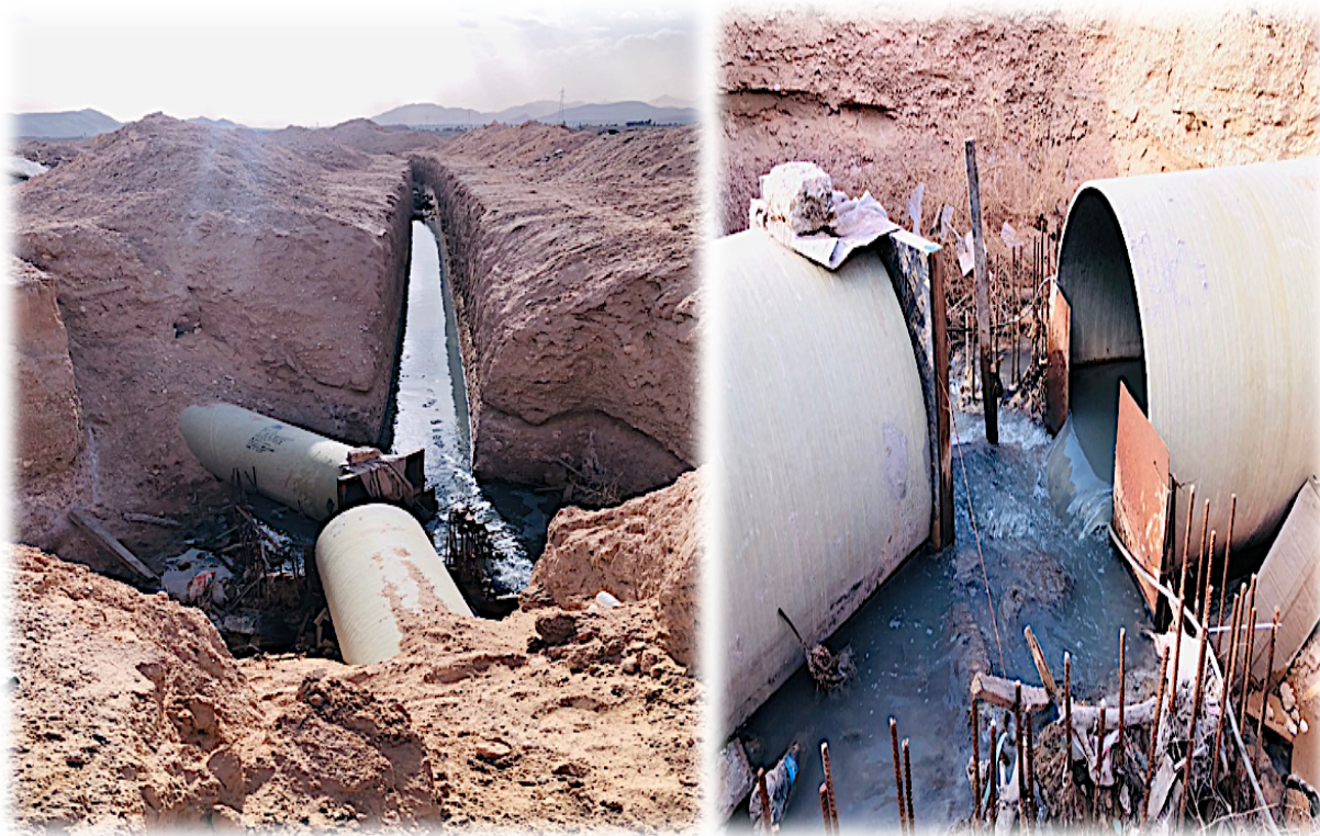
Figure 15: Site V-Rejet Pôle Urbain Biskra (Photos prises le 06 Décembre 2021).
