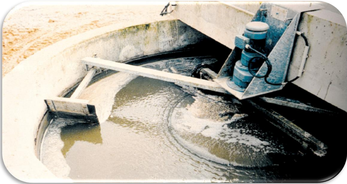
Figure08: Dégraissage –Déshuilage [5].
