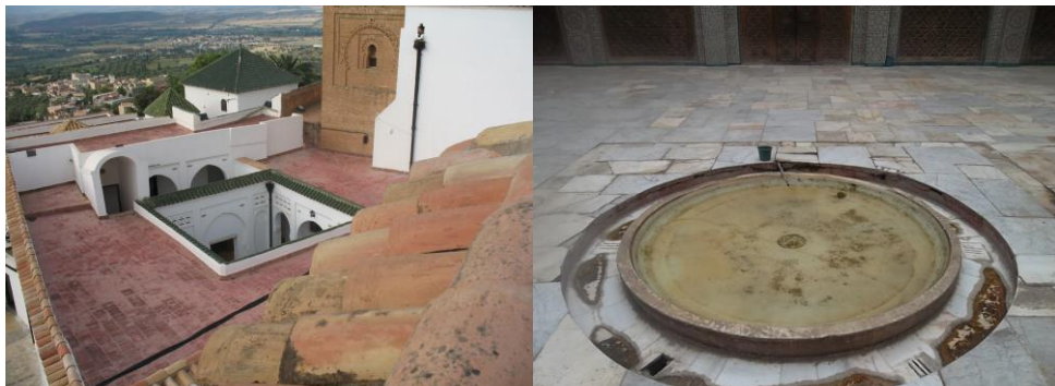
Figure V.11 : A gauche : la forme compacte de la medersa d'el-c'eubbād (Tlemcen), à droite : le bassin d'eau comme dispositif de rafraîchissement passif par évaporation dans la medersa el-Bou'c'nāniyya (Fès)
