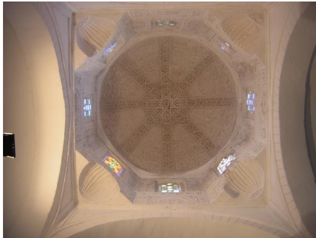
Figure V.8 : Une coupole dotée de percements
