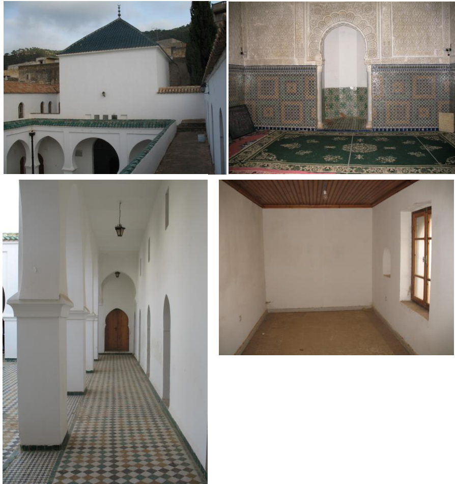
Figure II.25 : L'état actuel de l'édifice après les transformations menées durant la période coloniale : La terrasse en haut à gauche, la salle de prière en haut à droite, la galerie en bas à gauche et la chambre de l'étage en bas à droite
