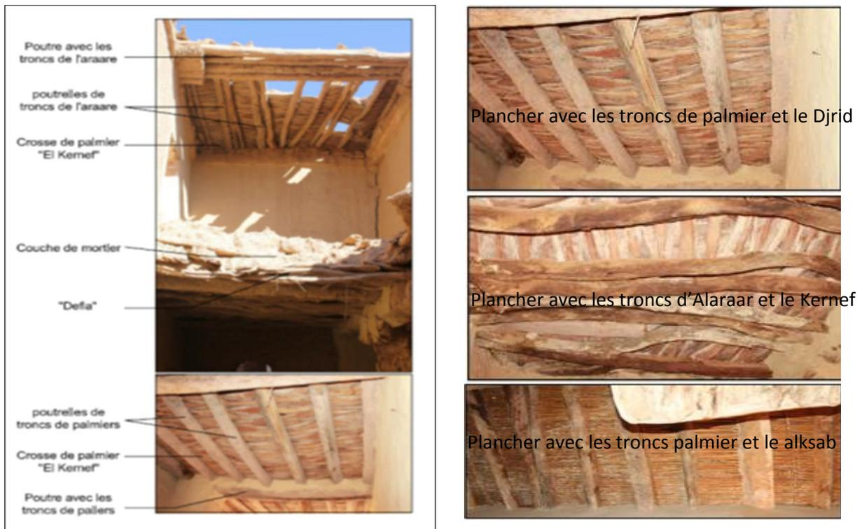
**Figure.7.21** : Les différentes composantes du plancher dans le ksar de Boussemgoun (Auteur, 2014)
