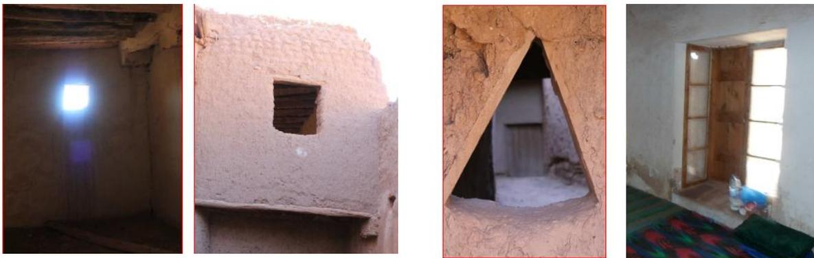
Figure.7.25 : Les différentes types d'ouvertures du ksar de Boussemgoun (Auteur, 2014)
