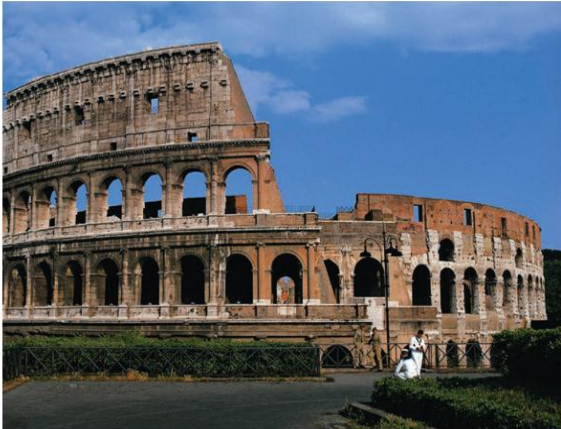
Figure I-23 : Style romain : le Colisée construit en brique et en béton, Italie. Source : CHING et al, 2011.
