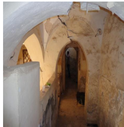
Figure 08-10 : Couverture en voûte. Source : OGEBC Ouargla, 2016.
