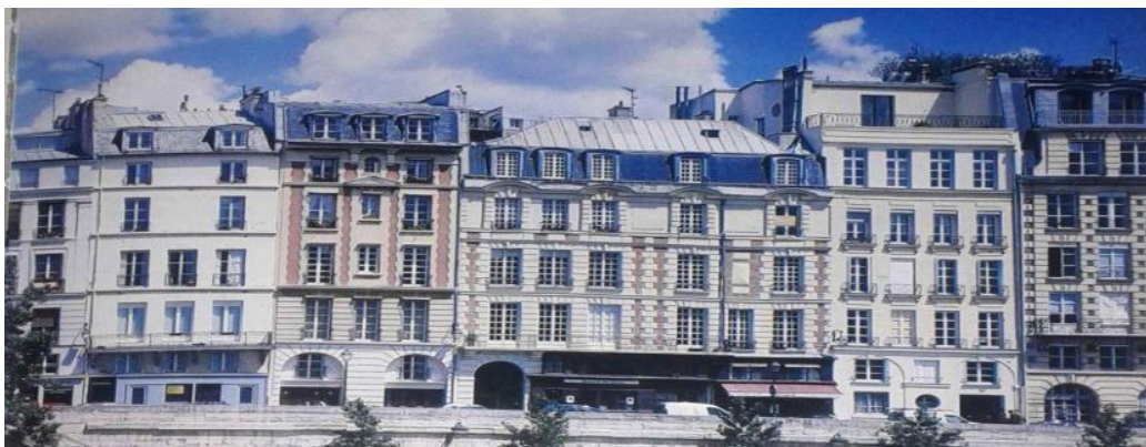
Figure I-03 : Façade urbaine homogène, Place Dauphine, Paris. Source : GAUTHIEZ, 2003.
