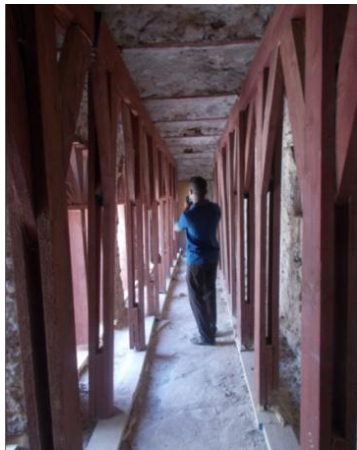
Figure VIII-09 : Plancher en voûtains. Source : Auteur.
