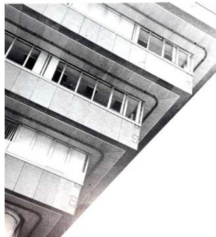
Figure I-31 : Encorbellement. Source : GAUTHIEZ, 2003.
