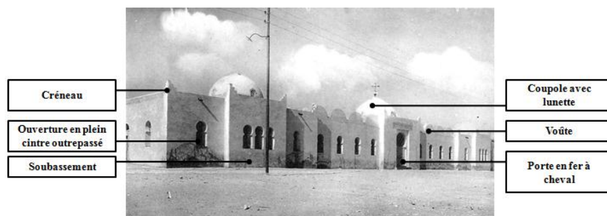
Figure VII-38 : Eléments de la façade de l’Ecole Mixte –Touggourt- Source : OGEBC Ouargla, 2016, fait par l’auteur.
