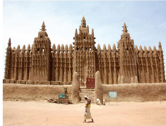
Figure I-24 : Style néo-soudanais : la Mosquée de Djenné construit en brique de terre, Mali. Source : CHING et al, 2011.
