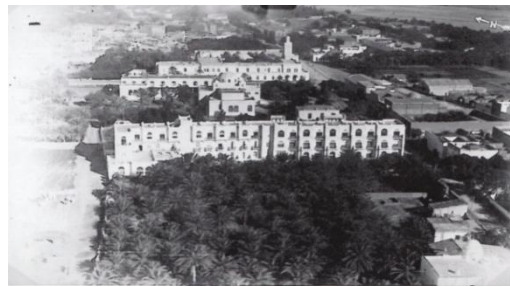
Figure V-25 : Echelle de la façade de l'Hôtel Transatlantique.
