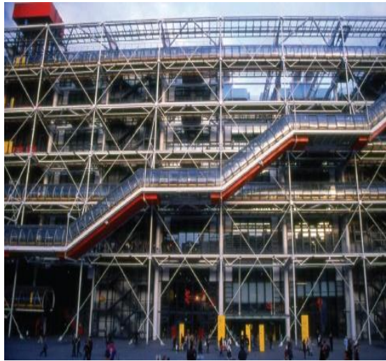
Figure II-15 : Le Centre Culturel George Pompidou, France. Source : CHING et al, 2011.
