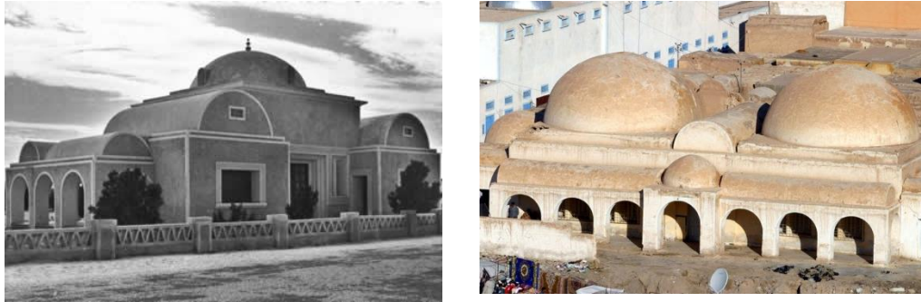
Figure IX-26 : Toiture en coupes et voûtes, à gauche le Petit Musée et à droite le Café des Combattants –El Oued- Source : DUCH d’El Oued, 2016.
