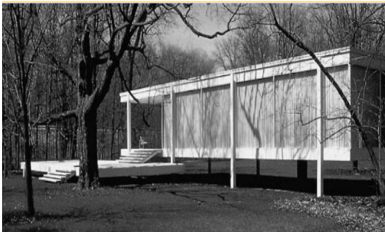
Figure I-14 : Articulation par vide et pilotis, Farnsworth House de Mies van der Rohe, Illinois, 1945-1950.
