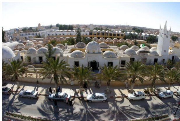
Figure IX-33 : Vue sur la toiture de l'Hôtel Transatlantique –El Oued- Source : DUCH d'El Oued, 2016.
