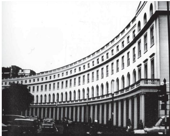
Figure I-02 : Façade de Park Crescent à London par John Nash. Source : KRIER, 1979.
