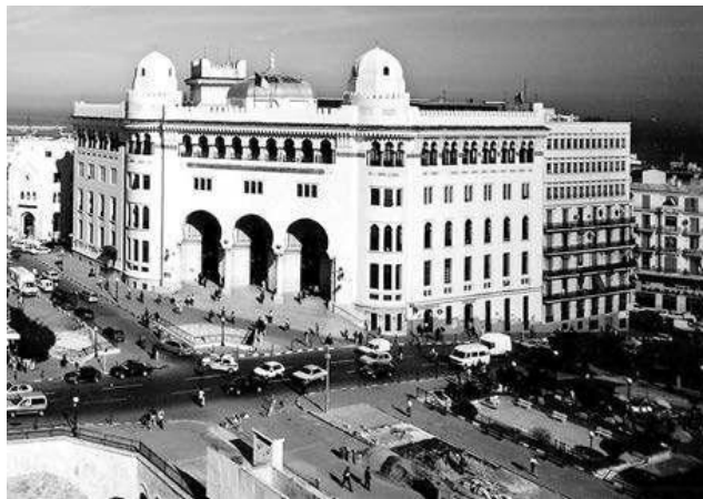
Figure II-40 : La façade principale de la Grande Poste d'Alger. Source : CHERIF, 2017.
