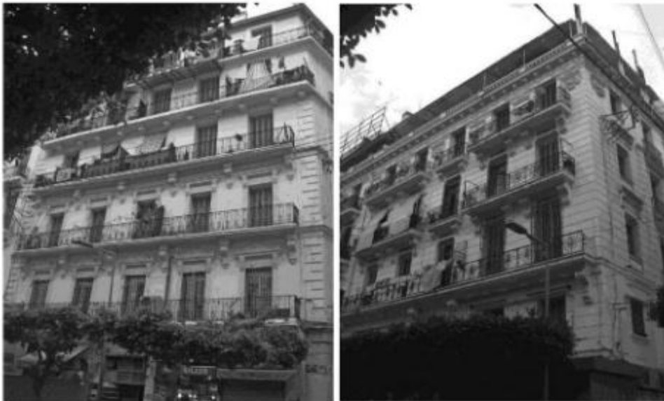
Figure II-47 : Deux immeubles de la rue Larbi Ben M'hidi illustrant les opérations de ravalement des façades.
