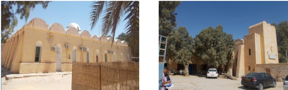
Figure IX-44 : Edifices à contreforts, de gauche à droite, l'Ouvroir des Sœurs Blanches, Eglise des Pères Blancs -Touggourt-
