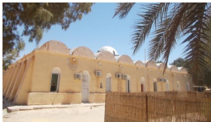
Figure IX-55 : Toiture en coupoles et voûtes ventilées, Ouvroir des Sœurs Blanches -Touggourt- Source : Auteur
