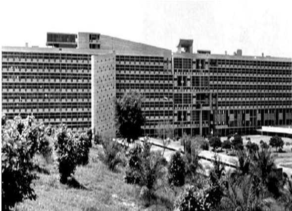
Figure I-26 : Le Corbusier ; Bâtiment de Secrétariat de Chandigarh, Inde. Source : ROTH et ROCH, 2014.
