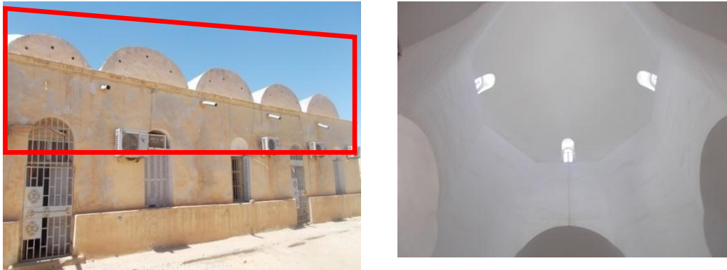
Figure VII-47 : Coupole et voûtes ventilés de l'Ouvreir.
