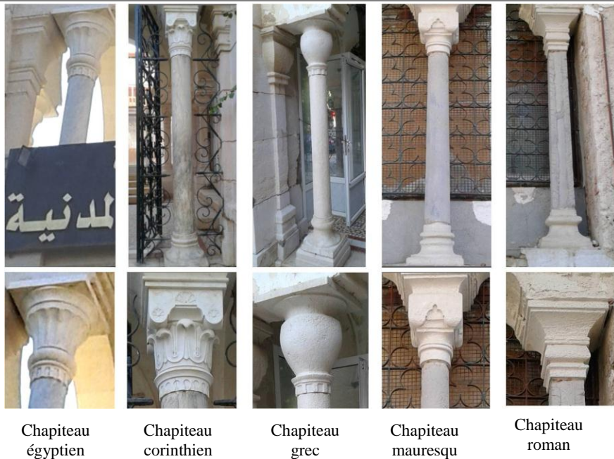
Figure V-49 : Types des colonnes et chapiteaux utilisés à l’Hôtel de Ville. Source : Auteur.
