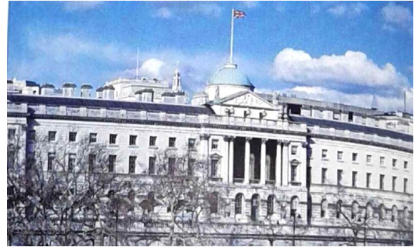
Figure II-07 : Façade de Style Néoclassique, Somerest House, Londres, Angleterre, 1776.
