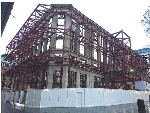
Figure II-46 : La façade à 48 Leicester Square en Janvier 2015, après la démolition du bâtiment derrière elle.
