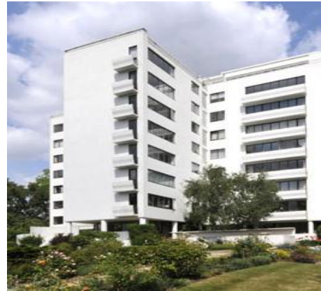
Figure II-14 : Façade de style International.
