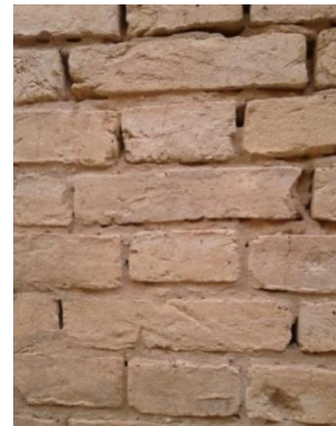
Figure V-20 : Appareillage de la pierre de taille. Source : Auteur.
