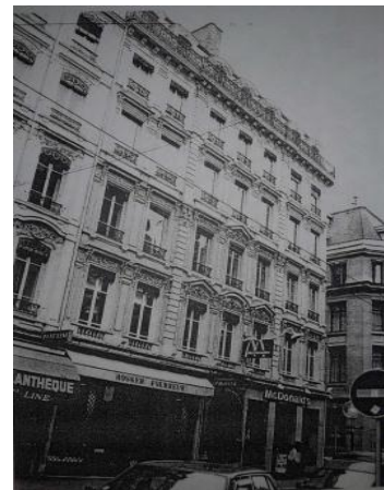
Figure III-05 : Structuration lysée en travées délimitées par la modénature.
