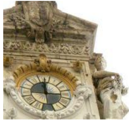
Figure II-31 : Pignon du Palais Consulaire. Source : BELOUHRANI, 2003.
