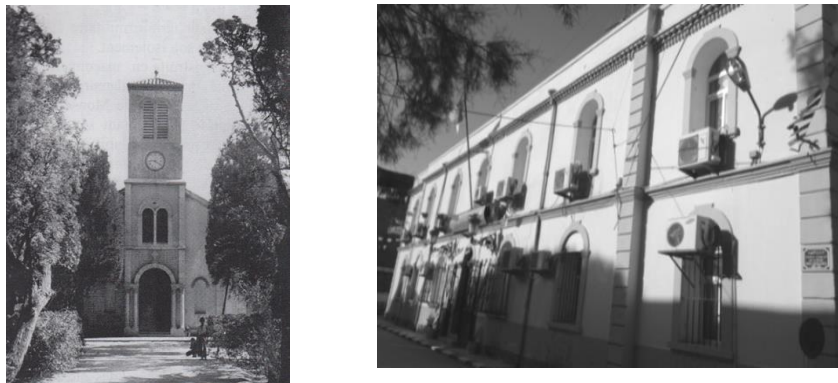
Figure IX-06 : Edifices bâtis en pierre, de gauche à droite, Hôtel de Ville, Caserne de Gendarmerie -Biskra- Source : PIZZAFERRI, 2011 ; auteur.
