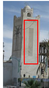
Figure IX-31 : Panneau de claustras, Minaret de Dar Diaf -El Oued- Source : Auteur.
