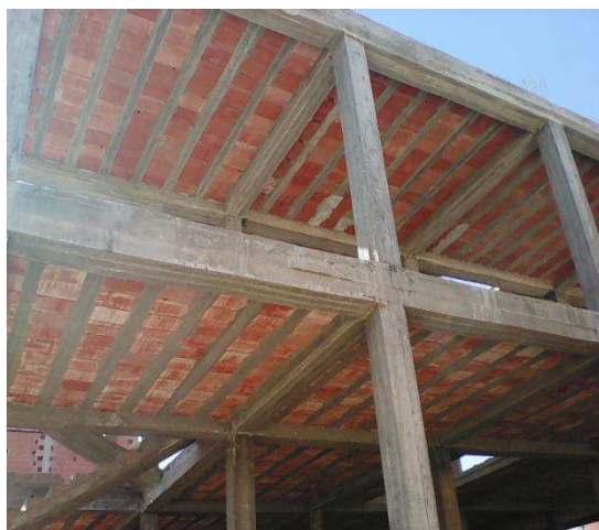
Figure 4.16 : Présentation deux types de dalles, réalisés à Biskra l'un avec un hourdi en béton et l'autre en brique. (Source : Auteur, 2016)
