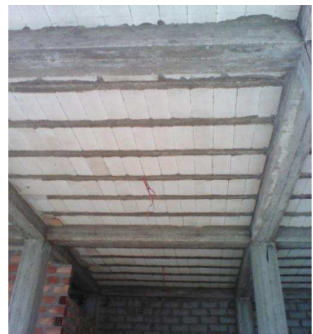
Figure 4.16 : Présentation deux types de dalles, réalisés à Biskra l'un avec un hourdi en béton et l'autre en brique. (Source : Auteur, 2016)
