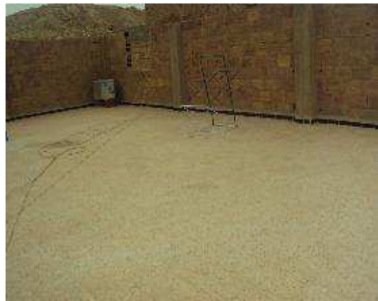
Figure 4.18 : Terrasse accessible avec un revêtement en carrelage. (Source : Auteur, 2016)
