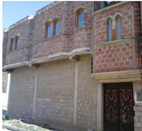
Figure 4.14 : Un exemple d'habitation construite avec un système de portique et des murs en maçonnerie mixte de brique et parpaing creux. (Source : Auteur, 2016)
