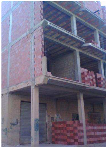
Figure 4.14 : Un exemple d'habitation construite avec un système de portique et des murs en maçonnerie mixte de brique et parpaing creux. (Source : Auteur, 2016)
