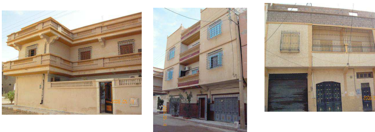
Figure 3.24 :Expression architecturale de la maison en lotissement, extraversion et décorations. (Source : Sriti, 2013).
