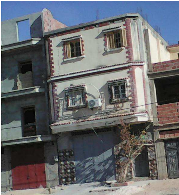
Figure 4.12 : Menuiserie en bois des fenêtres (Source : Auteur, 2016)
