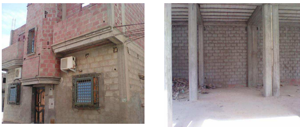
Figure 3.25 :Système constructif basé sur l'utilisation du béton dans les lotissements planifiés. (Source : Auteur, 2017).
