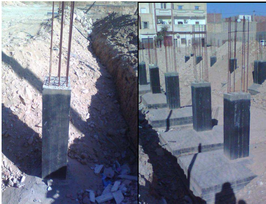
Figure 2.3 : Semelle d'une habitation en cours de réalisation. (Source : Auteur, 2016)
