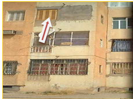
Photo.23: Transformation du balcon en une fenêtre
