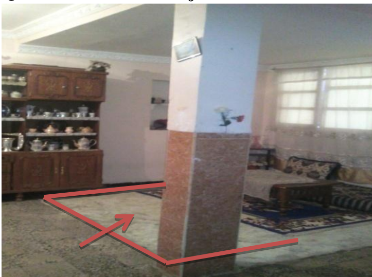
Photo.1: Rajout du balcon au séjour
