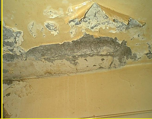
Photo.57: Etanchéité des toitures
