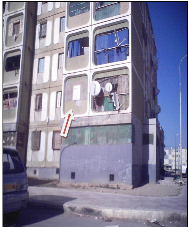
Photo.36: Transformation du balcon en une fenêtre
