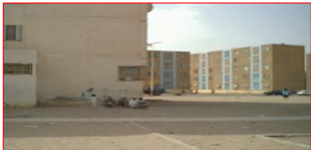
Photo.66: Regroupement des jeunes et des personnes âgées près des logements ou auprès des parkings présentant une source de gêne pour les habitants
