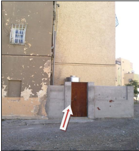
Photo.46: Création d'une clôture au RDC
