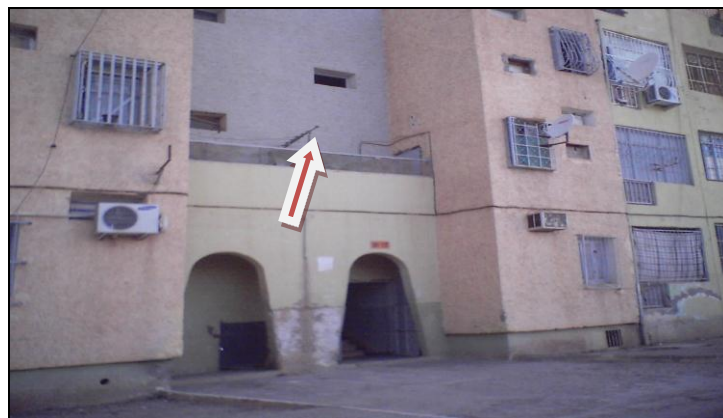
Photo.42: Transformation d'une terrasse inaccessible
