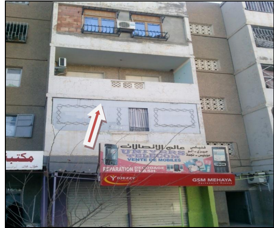
Photo.28: Transformation du balcon en une fenêtre
