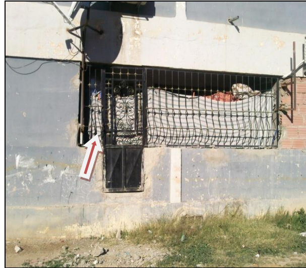
Photo.47: Création d'une entrée en façade postérieure
