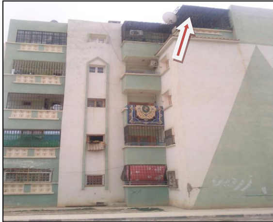
Photo.38: Création d'une chambre dans la terrasse
