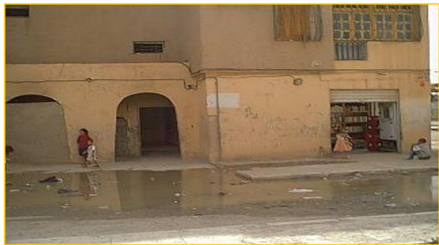
Photo.64: Stagnation des eaux auprès des immeubles
