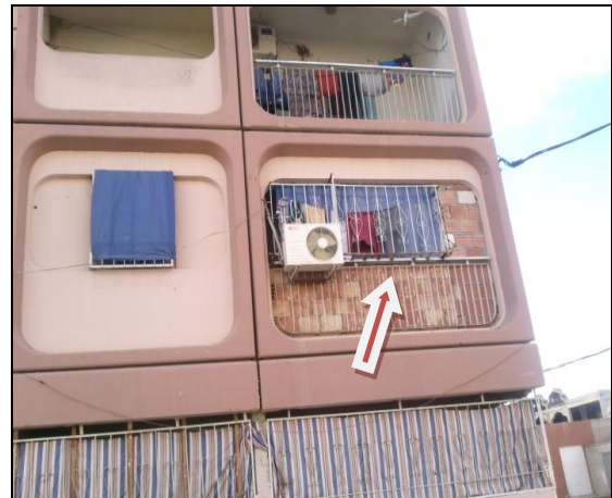
Photo.30: Surélévation du mur du balcon
