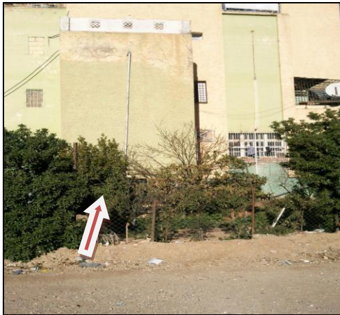
Photo.43: Création du jardin au RDC
