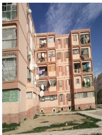
Photo.8: Espace extérieur immédiat non aménagé
