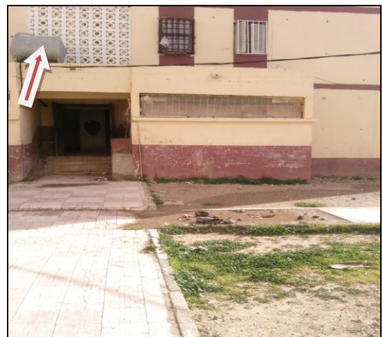
Photo.41: Installation de citerne en façade
