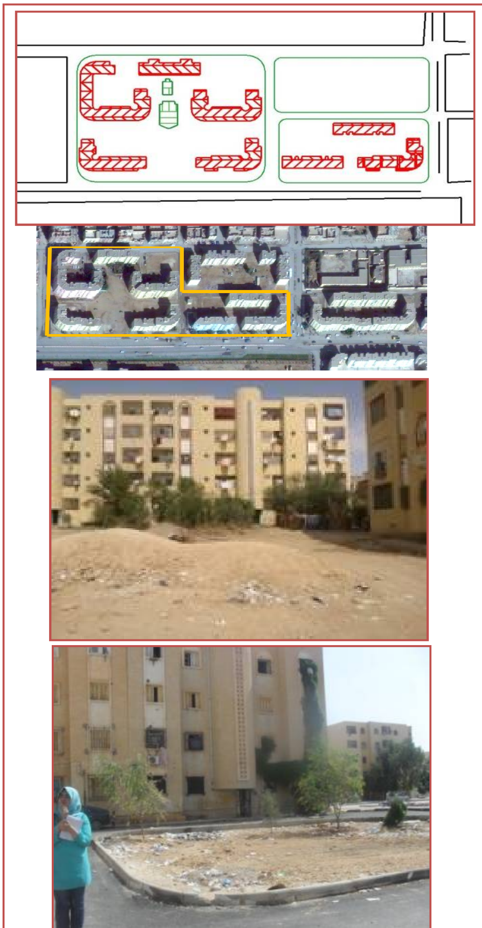
Figure n°4 : Cité des 300 Logts (blocs en U).
