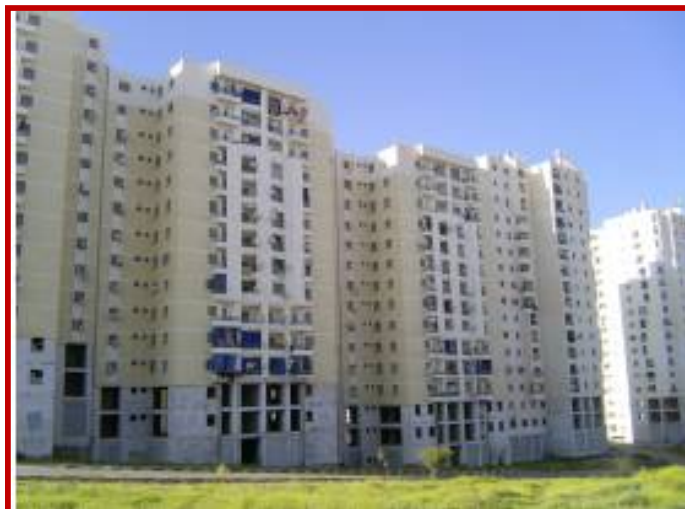
Photo n°27 : Logements location-vente à l'UV07 Constantine-nouvelle ville Ali Mendjeli.
