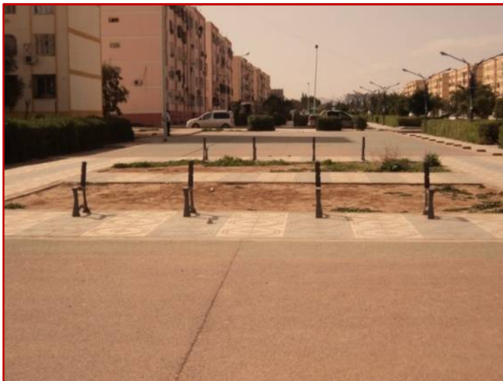
Photo n°6,7 : Des espaces communautaires saccagés et vandalisés.
