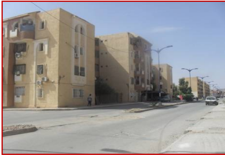
Photo n°5 /La cité des 240 Logts, Z.H.U.N ouest.
