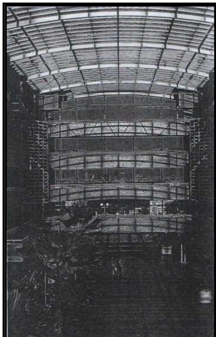
Figure I. 63. La galerie hospitalière de l'hôpital de Percy à Clamart. Source: (FERMAND, 1999).
