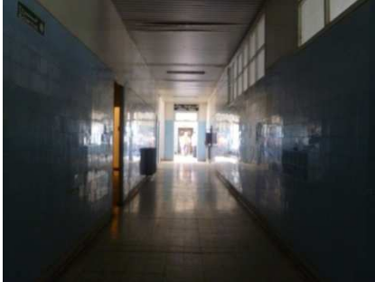
Annexe XIII- figure. 29. Vue sur la galerie publique du service de la chirurgie générale. Etat normale. Source: auteur.
