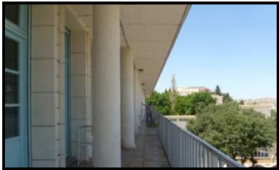
Figure VI. 25. Vue sur la coursive publique du service de la chirurgie générale-hommes. Source: Auteur.
