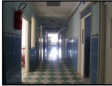
Figure VI. 141. Vue sur le couloir d'accueil du service de la médecine interne « hommes » du bloc B de l'hôpital Ain Azel, 2011.
