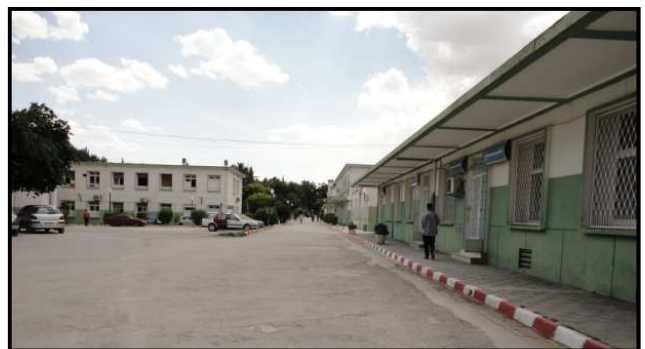
Figure VI. 77. Vue sur l'axe principal de circulation à l'intérieur de l'hôpital Saint Arnaud d'El Eulma, 2011. Source : auteur.
