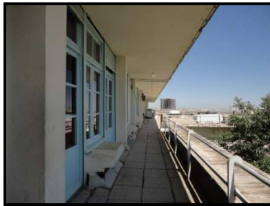
Figure VI. 32. Vue sur la coursive de visite des malades réanimés à l'extérieur du service de la neurochirurgie. Source: Auteur.
