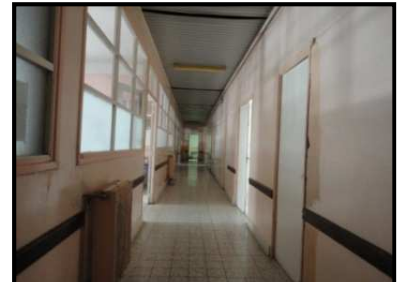
Figure VI. 27. Vue sur le couloir du service de la chirurgie générale-femmes. Source: Auteur.
