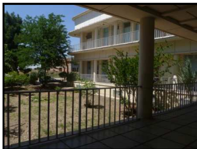
Figure VI. 14. Vue sur le patio depuis la terrasse. Source: Auteur.
