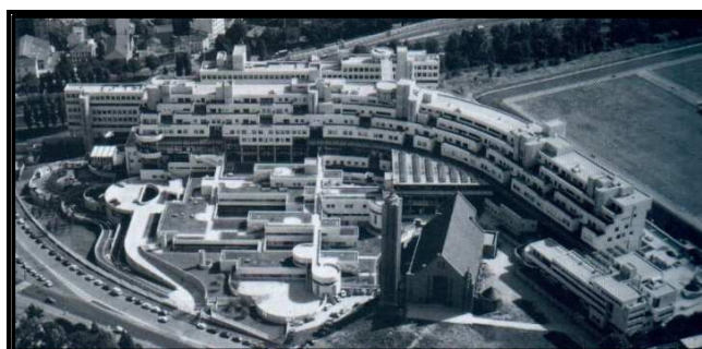
Figure I. 54. Vue d'ensemble de l'hôpital pédiatrique Robert Debré réalisé par P. Riboulet. Source: (FERMAND, 1999).
