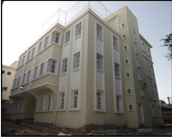
Figure VI. 65. Vue sur le centre de désintoxication, Juillet 2011. Source: Auteur.
