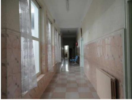
Annexe XIII- figure. 49. Vue sur l'espace d'accueil et d'attente du service de la chirurgie générale femmes. Etat normale. Source: auteur.
