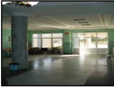
Figure VI. 117. Vue sur le hall d'entrée principal du bloc A. Source: Auteur, 2011.
