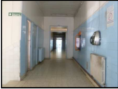
Figure VI. 22. Vue sur la galerie technique du premier étage avec ces contrastes lumineux. Source: Auteur.
