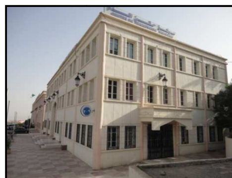
Figure VI. 62. Vue sur le centre de transfusion sanguine du CHU de Sétif, état Juin 2011. Source: Auteur.
