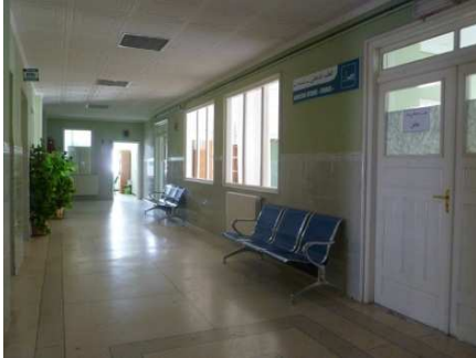
Annexe XIII- figure. 5. Vue sur l'espace d'accueil et d'attente du service de la médecine interne femmes. Etat normale. Source: auteur.
