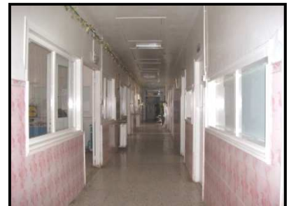
Figure VI. 86. Vue sur le couloir d'accueil du service de la médecine interne –côté femmes-. Source: Auteur.
