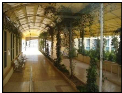
Figure VI. 127. Vue sur la galerie publique couverte ouverte du bloc B de l'hôpital Ain Azel, 2011. Source: Auteur.
