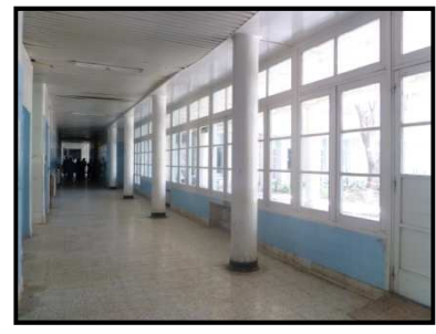
Figure VI. 16. Vue sur la galerie publique du RDC. Source: Auteur.
