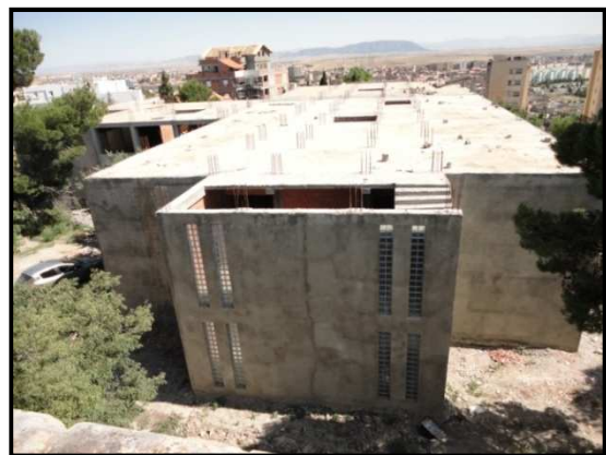
Figure VI. 67. Vue sur le nouveau pavillon de la neurochirurgie, en cours de construction, état Juillet 2011. Source: Auteur.
