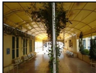
Figure VI. 129. Vue sur la galerie publique du bloc B de l'hôpital Ain Azel, 2011. Source: Auteur.
