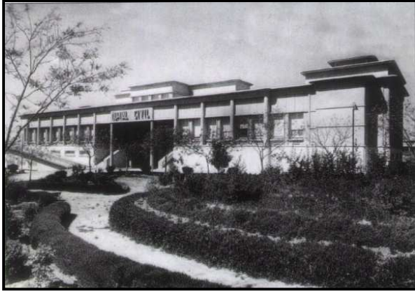
Figure VI. 8. Vue sur l'ancienne entrée principale du CHU de Sétif, 1939. Source: la collection photographique de Sétif de ma jeunesse.
