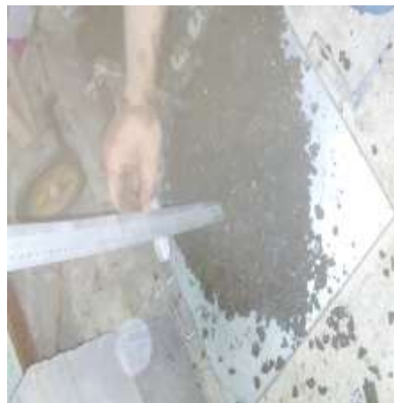
(c) Mesure l'affaissement du béton.
