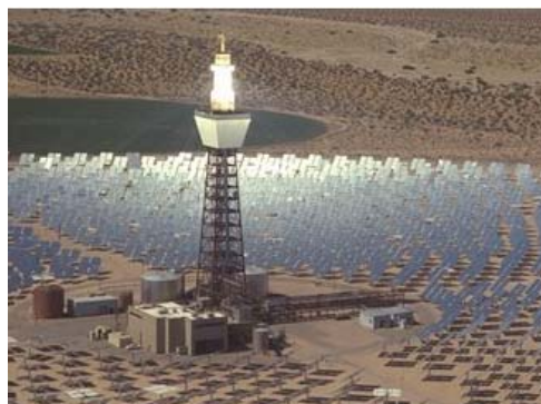
Figure II.20 : Système de centrale à tour [32]
