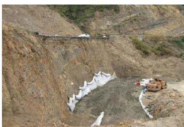
Mise en œuvre des couches de TVO de 30 cm.
