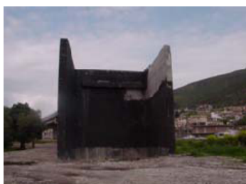
Vue de l'Ouvrage d'Art
