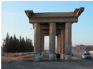
Vue de l'ouvrage d'Art
