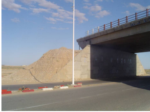
Vue de l'ouvrage d'Art
