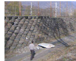
Fig. 1.15. Un parement en Pneusol
