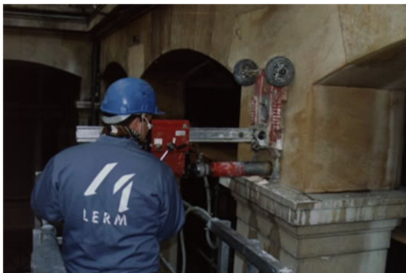
Photo (II.3) : Carottage électrique à la couronne diamantée de 20 à 110 mm de diamètre
