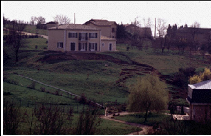
Figure.IV.2 Maison sera endommagée par le fait d'être située sur une masse de décollement réactivée
