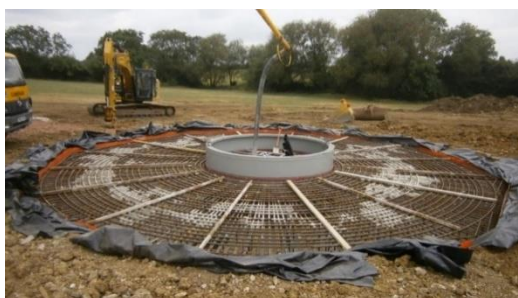
Fig.II.1. Fondation d'une éolienne [WEB1].
