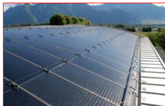
Figure II.4 : Toiture solaire sans vitrage en acier inoxydable
