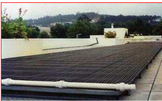
Figure II.3 : Moquette solaire caoutchouc
