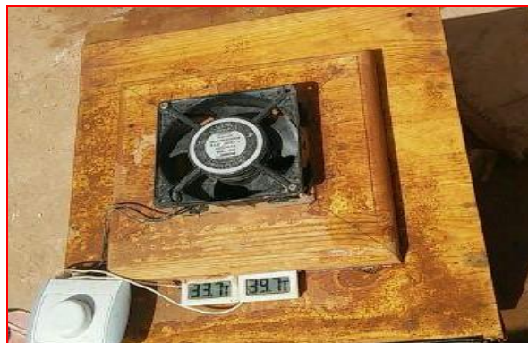
Figure V.13 : Photo du ventilateur centrifuge installé sur la cheminé de la chambre de séchage
