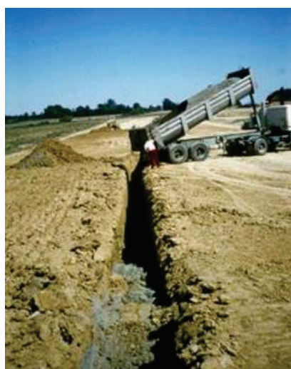
Fig. 7 Réalisation d'un drain vertical avec un sable 0-5 mm. (Irstea bordeaux, 2011)
