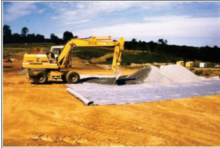
Fig. 3 Réalisation d'un tapis drainant. (Irstea-G2DR 2011)
