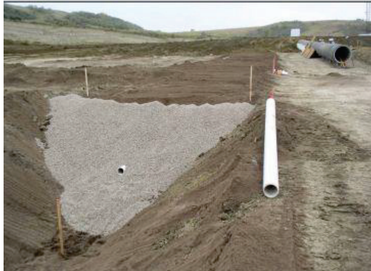
Fig. 12 drainage par tranchée en cour de réalisation. (Pabst et al. 2011)
