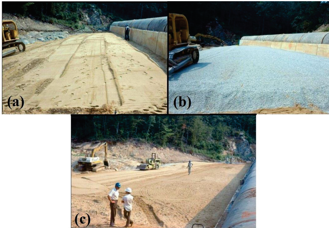
Fig. 4 La mise en place d'un tapis drainant. (NRCS, Alabama 2011)
