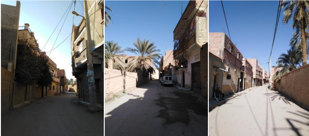
Figure IV.7. Photos de quelques rues de quartier « Hai M'cid ».
