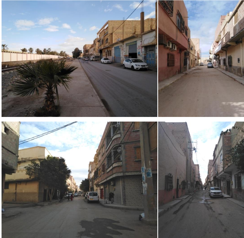
Figure IV.16. Photos de quelques rues de quartier '(Hai Ferhat)'
