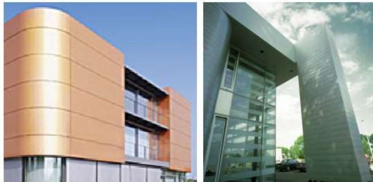
Figure II.19: Façade à panneaux métalliques (source_alucoband.com)
