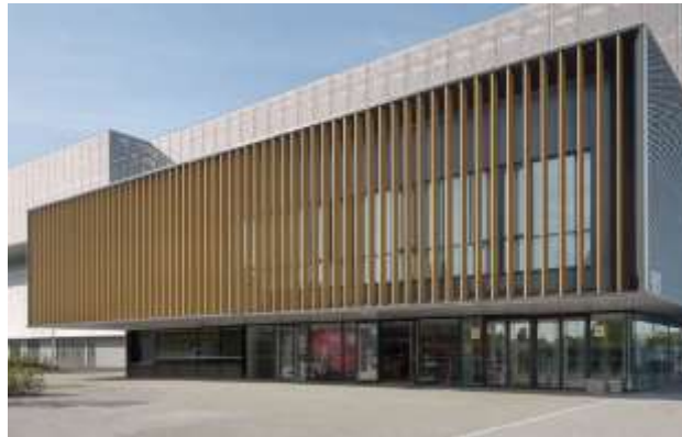
Figure I.2: Protection solaire des fenêtres (source : Trust. < www.trustaluver.com >)
