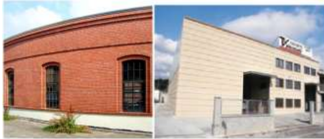
Figure II.18 : Façade en brique (a) brique en terre cuite ; b) brique en béton (source : Archiexpo)
