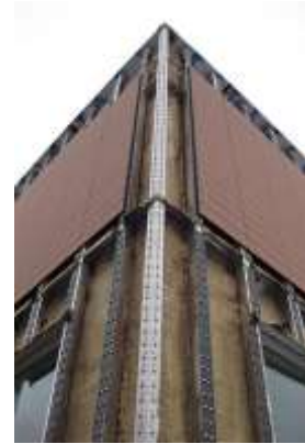
Figure II.22 : Façade ventilée (source : voivert.ca)
