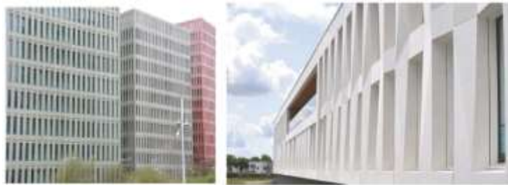
Figure II.16 : Façade lourde en béton (source : le moniteur)
