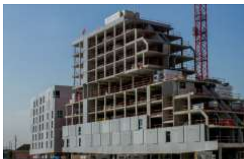
Figure II.17: Façade en béton préfabriqué (source : le moniteur)
