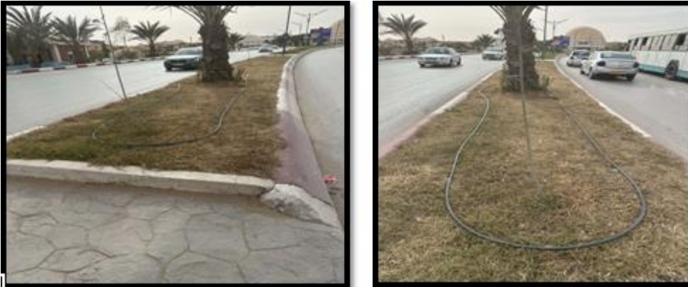
صورة 41 : نظام الري بالتنقيط في بلدية بسكرة (التقاط الطالبة/الطريق المؤدي للمتحف الجهوي)
