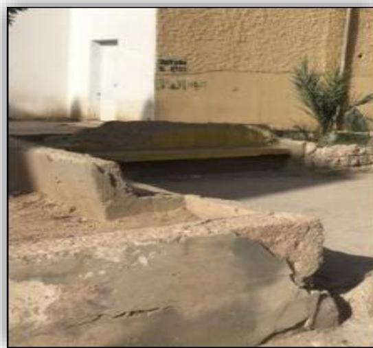
Image 12: des bancs construit en béton cassés. Source : prise par l'étudiante.
