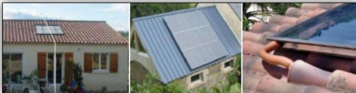
Image 2: intégration du capteur sur une toiture en pente.
