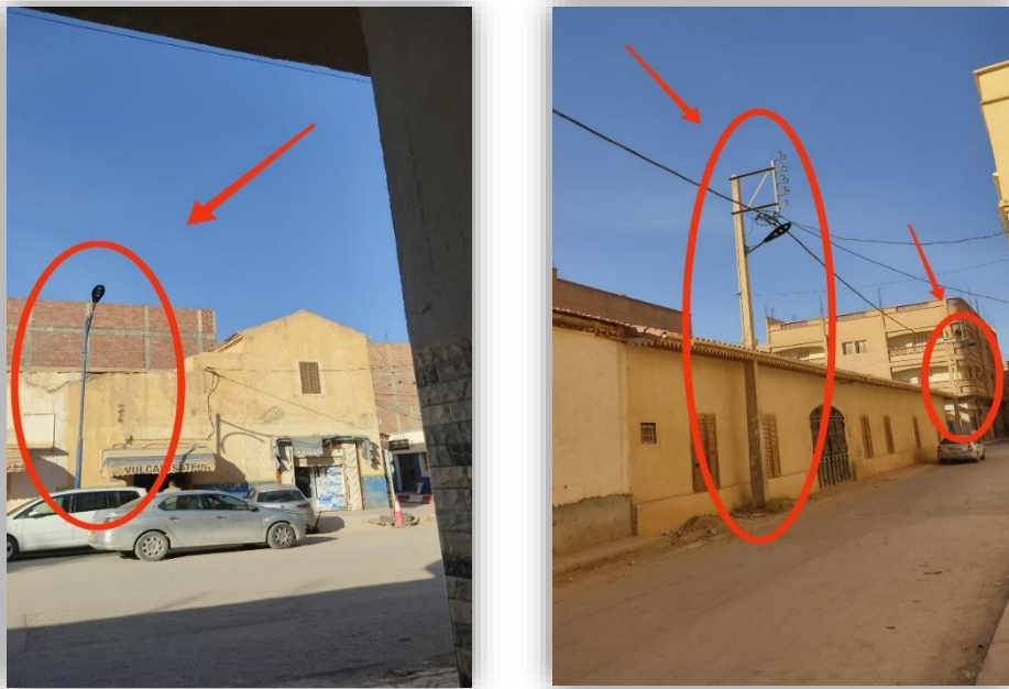
Image 11: l'état dégradé du mobilier urbain.
