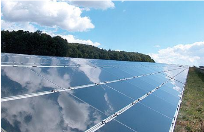
Fig I. 12: modules verre-verre au Telluride de Cadmium, efficacité de 9 à 11%.
